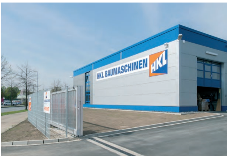
Das HKL BAUMASCHINEN Center wird als Mietcenter mit Werkstatt einschließlich Außenanlagen mit Waschplatz und Abscheidertechnik sowie einem großen Bau-shop betrieben.
