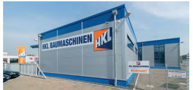
Generalunternehmer war die Stricker Projektgesellschaft, welche die schlüsselfertige Realisierung des Bauvorhabens umsetzte.
