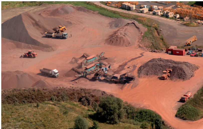
Luftbild des externen Aufbereitungsplatzes mit dem mobilen Splittwerk.
